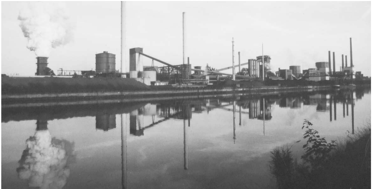
Foto: Jürgen Görs – Stahlwerke Salzgitter
