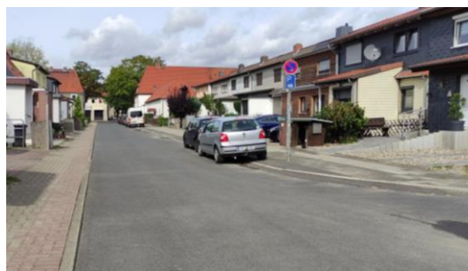
Reihenhäuser südöstlich des NP-Marktes
