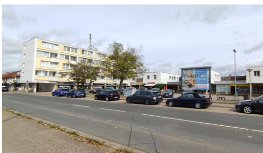
Parkplatz, südlicher ZVB Schölkegraben
